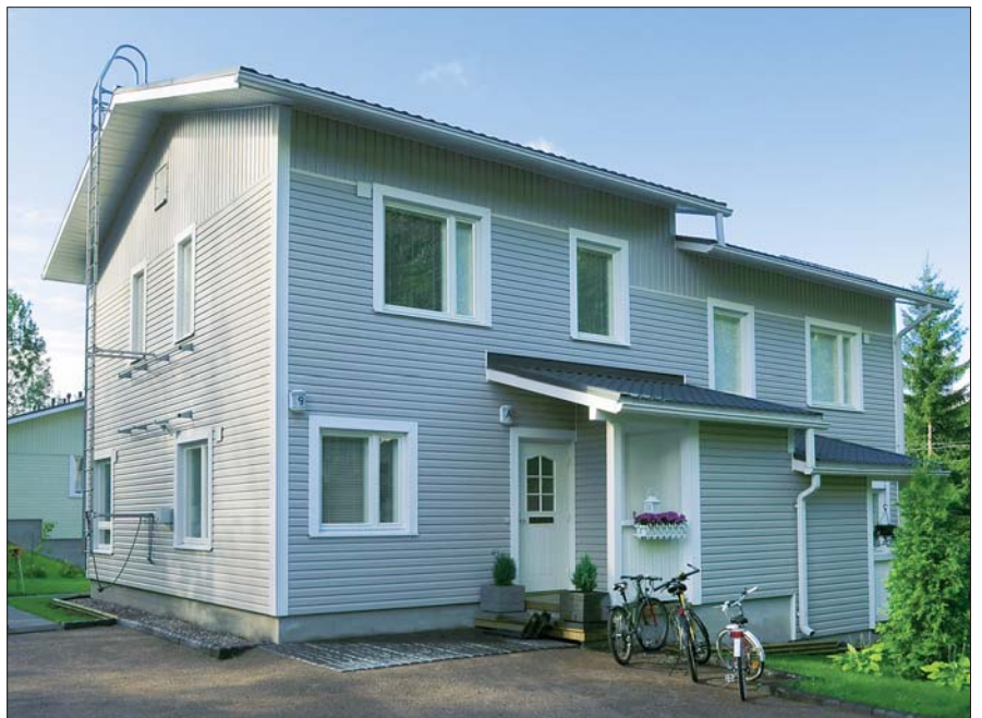
Kaycan-profiililevyillä verhottu asuinrakennus. Vaakoprofiili on nro 0063 ja pystyprofiili nro 0235, väri nro 8, vaalea harmaa.
