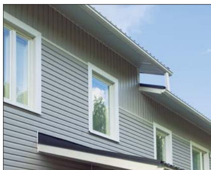
Ikkunanpielet ja nurkat viimeistellään Kaycan-listoilla, joiden materiaalina on myös Duratron-vinyylchloridi.
